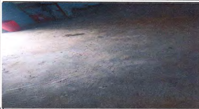
Foto 1: Base de concreto para cocina
