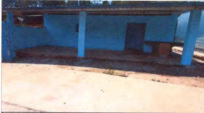
Foto 7: Aplicación cernido y de repello en paredes interiores y exteriores de módulo de aula
