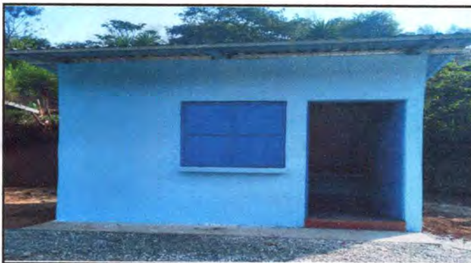
Foto 9: Sustitución de pared
