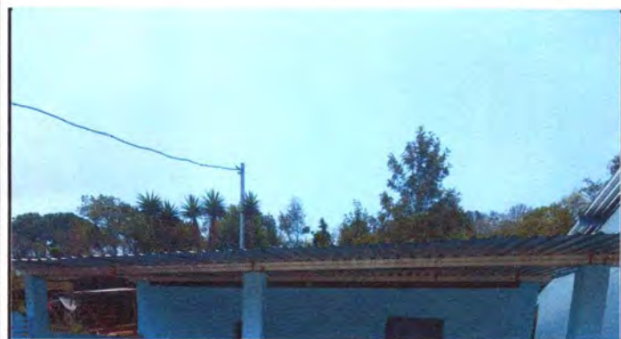
Foto 3: Cubierta de lámina
