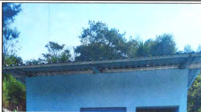
Foto 2: Estructura de techo
