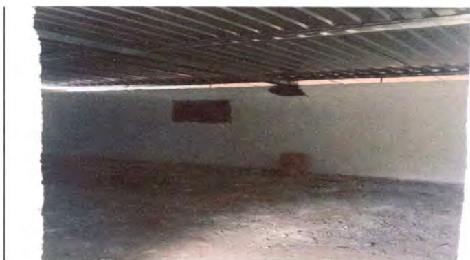
Foto 3: Cubierta de lámina
