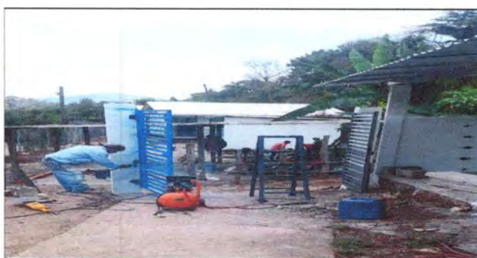
Foto 6: Portón de metal de 2.50 de ancho por 2.10 de alto
