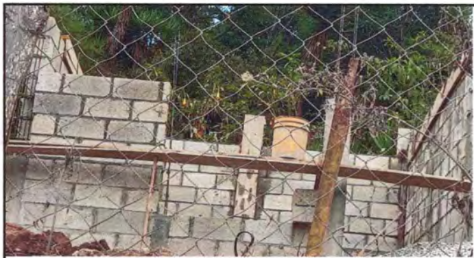
Foto 9: Sustitución de pared
