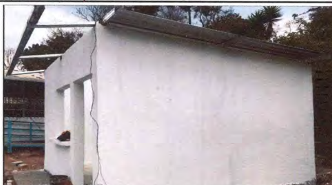
Foto 2: Estructura de techo
