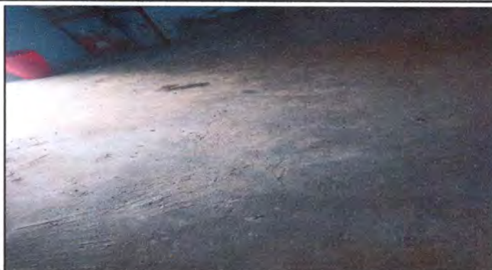
Foto 1: Base de concreto para cocina
