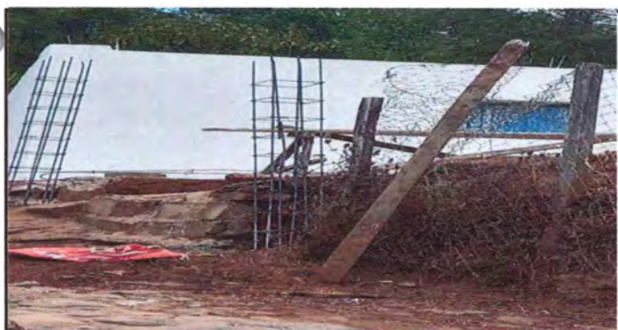
Foto 5: Fundición de columnas de concreto para reforzamiento de portón de ingreso
