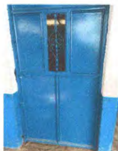
Foto 7: Puertas: Reparación de puertas de las aulas de: primero, tercero y sexto
