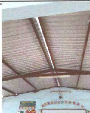
Foto 1: Cubierta de Lámina: ubicado en el salón del Centro Educativo
