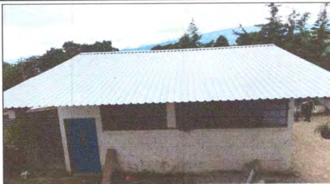
Foto 2: Cubierta de Lámina: ubicado en el salón de la entrada de la escuela
