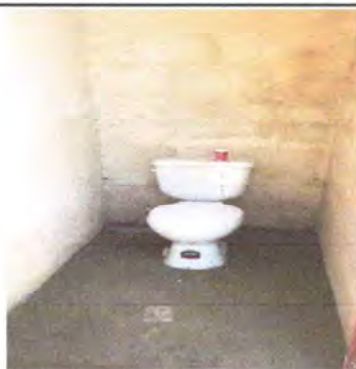
Foto 9: Sanitarios: Se repararon los sanitarios, por estar en mal estado y falta de profundidad de fosa.
