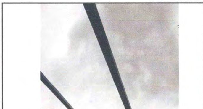
Foto 3: Estructura de techo (Pintura): Salón del Centro Educativo
