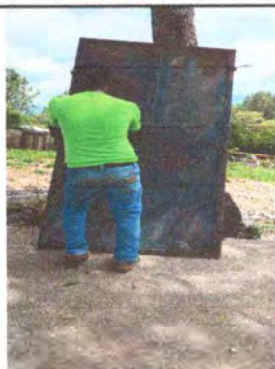
Foto 7: Puertas: Reparación de puertas de las aulas de: primero, tercero y sexto
