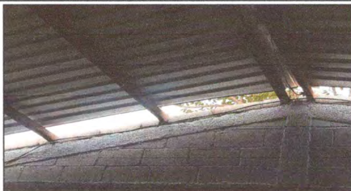
Foto 1: Cubierta de Lámina: ubicado en el salón del Centro Educativo
