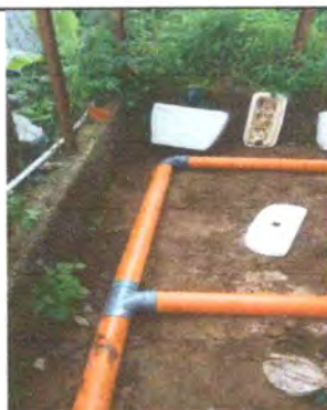
Foto 9: Sanitarios: Se repararon los sanitarios, por estar en mal estado y falta de profundidad de fosa.
