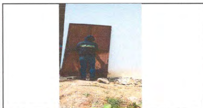
Foto 5: Puertas: Reparación de las puertas de: aula de entrada del centro educativo.
