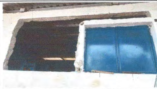
Foto 8: Ventanas: Se amplió ventana debido a falta de iluminación, en las aulas de los grados de Primero y Tercero
