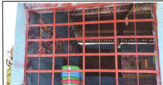
FINAL Sustitucion de ventanal
