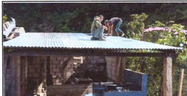
FINAL Cubierta de lámina
