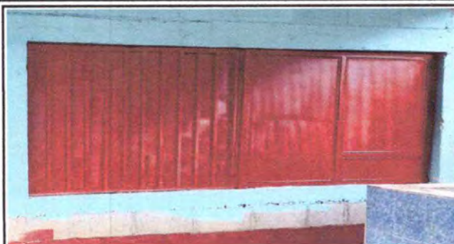
FINAL Instalacion de ventanas
