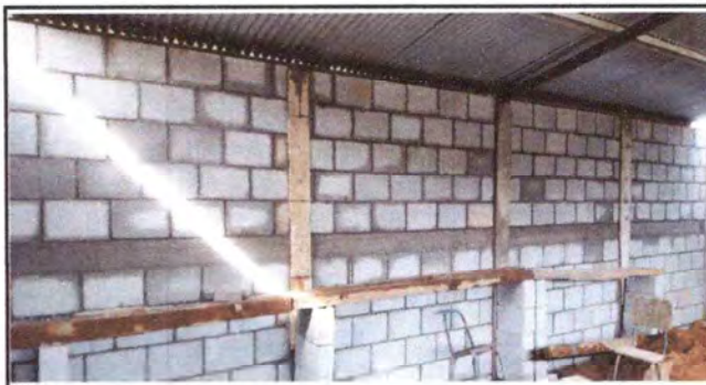
FINAL Reparación muro de contención
