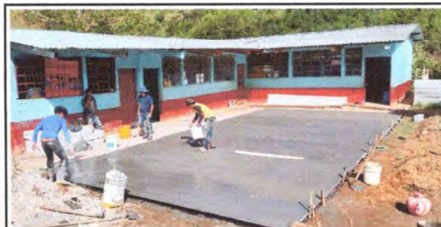
FINAL Sustitución de losa
