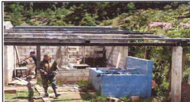
FINAL Sustitucion de estructura
