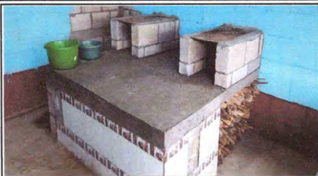
FINAL Reparación de estufa rural
