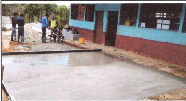
INTERMEDIO Sustitucion de losa
