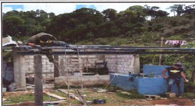
INTERMEDIO Sustitucion de estructura
