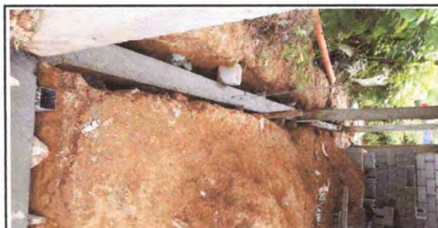
INTERMEDIO Reparacion de muro
