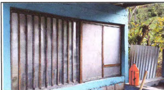
INTERMEDIO Instalacion de ventanas
