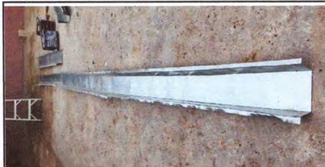
INTERMEDIO Sustitucion de canal de agua
