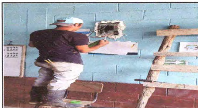
INTERMEDIO Reparacion de sistema electrico
