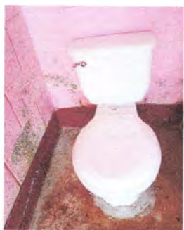
Foto 3: Cambio e instalación de agua en sanitarios
