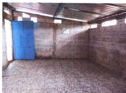
Foto 6: instalacion de piso.
