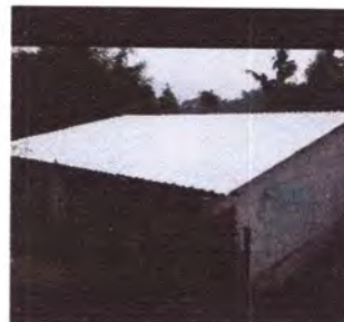
Foto 4: cambio e instalacion de techo.
