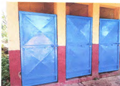
Foto1: reparacion y Pintado de puertas en sanitarios
