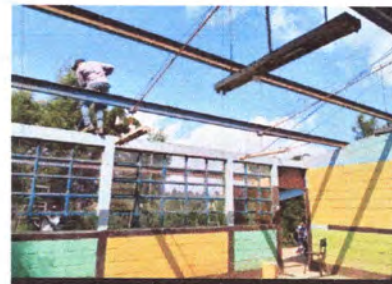
Foto 6: instalacion de techo.
