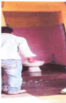
Foto 3: Instación de sanitarios
