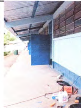
Foto 4: Instalación de puertas en las aulas
