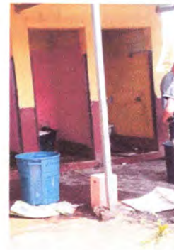
Foto 2: Retiro de puertas de los sanitarios
