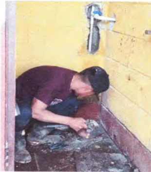
Foto1: Instalación de tubería de agua para sanitarios
