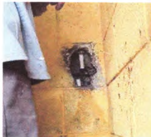
Foto 5: Reparación de red de agua y drenaje.
