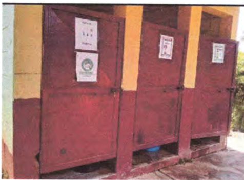
Foto 3: Reparación de puertas
