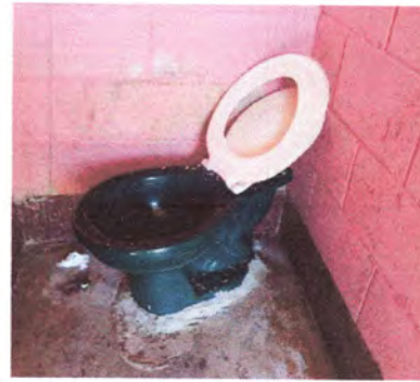
Foto 2: Reparación de agua en los sanitarios
