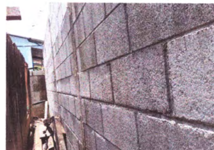
Foto 6: Reparación de pared
