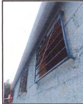
Foto 4: Instalación de canal de agua pluvial
