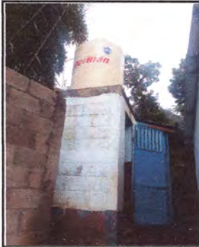
Foto 1: Cambio de tinaco
