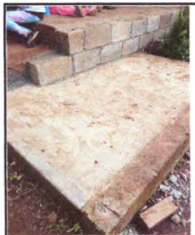
Foto 5: Restauración de losa de patio
