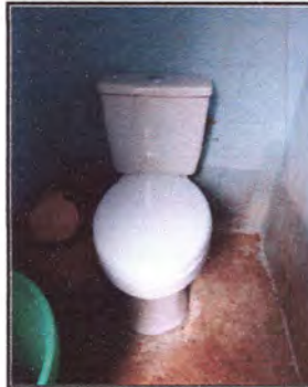
Foto 2: Cambio de inodoro
