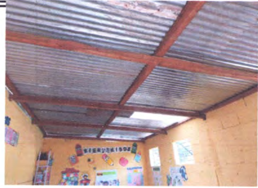
FOTO 2: Reemplazo soporte techo
