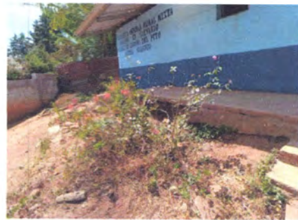
Foto4: Reparación de Losa en Patio
