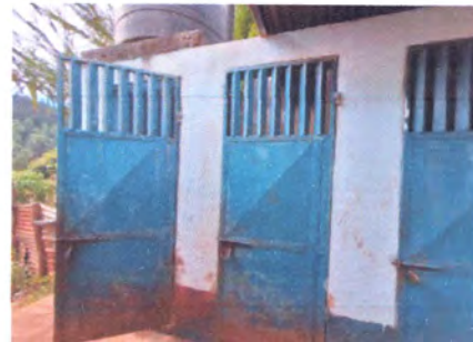
Foto: 6 Reparación de puertas de metal
