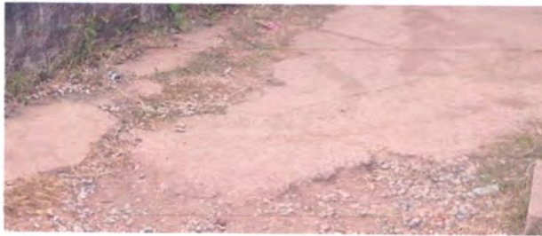
Foto: 5 Reparación de losa en patio
