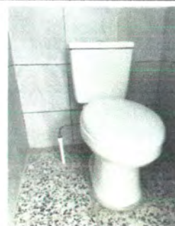
FOTO 2: Sustitución e instalación de inodoros
