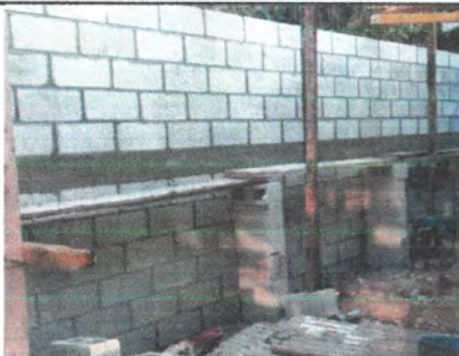
Foto: 5 Reparación de muro perimetral
