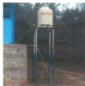
Foto: 5 Reparación de base para tinaco
