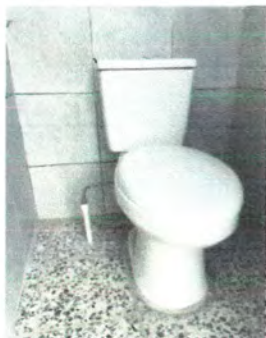
Foto1: Reparación de base de cemento para piso.
