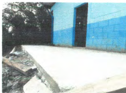
Foto4: Reparación de Losa en Patio
