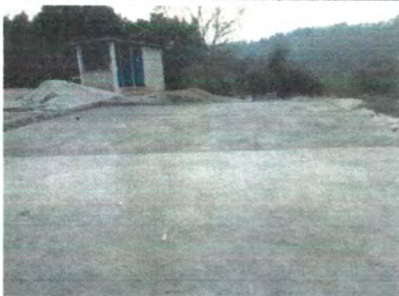
Foto3: Reparación de Losa en Patio
