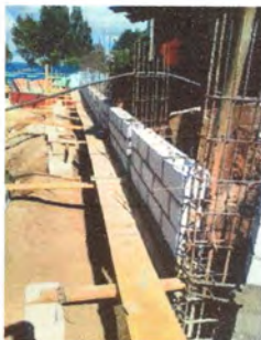
Foto: 5 Reparación de muro perimetral
