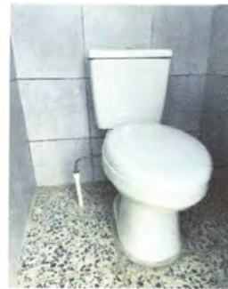
FOTO 2: Sustitución e instalación de inodoros
