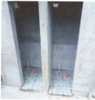
Foto1: Reparación de base de cemento para piso.
