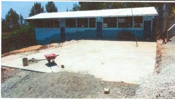
Foto3: Reparación de Losa en Patio
