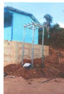
Foto: 5 Reparación de base para tinaco
