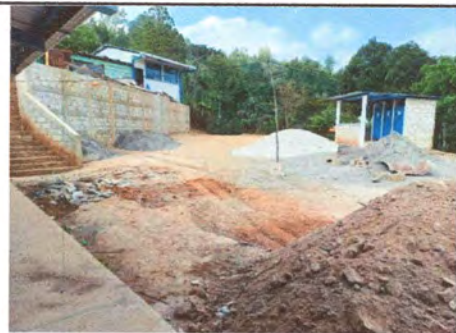
Foto4: Reparación de Losa en Patio
