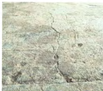
Foto4: Reparación de Losa en Patio
