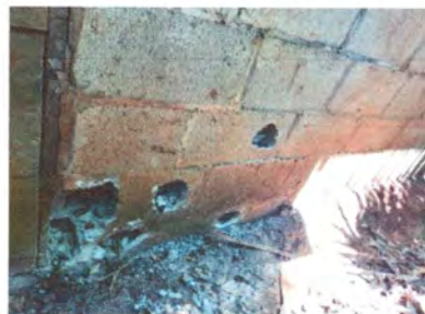
Foto: 6 Reparación de muro perimetral
