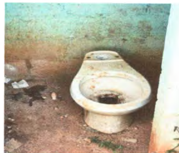
FOTO 2: Sustitución e instalación de inodoros
