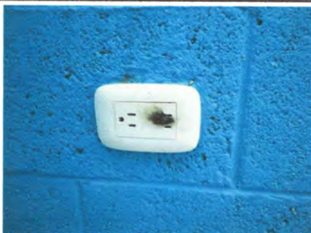
Foto: 5 Reparación de sistema eléctrico
