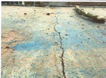
Foto3: Reparación de Losa en Patio
