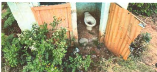
Foto1: Reparación de base de cemento para piso.
