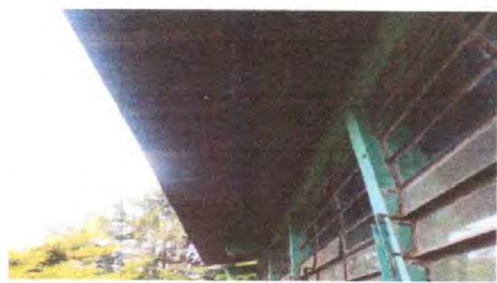
Foto 2: ESTRUCTURA DE TECHO (MANTENIMIENTO, LIJADA, APLICACIÓN A DOS MANOS DE PINTURA ANTICORROSIVA )
