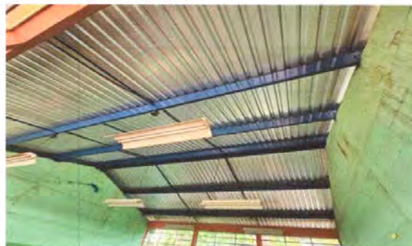
FOTO 2: ESTRUCTURA DE TECHO MANTENIMIENTO LIJADA APLICACIÓN A DOS MANOS DE PINTURA ANTICORROSIVA
