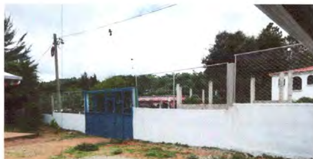
FOTO 4: MURO PERIMETRAL SUSTITUCION DE MALLA GALVANIZADA
