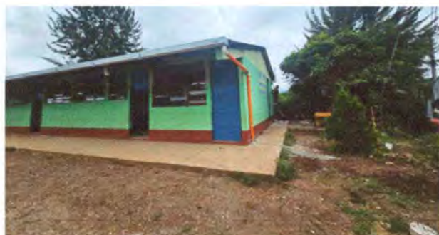
Foto 3: CANALES Y BAJADAS DE AGUA PLUVIAL, SUSTITUCION CANAL CUADRADO DE LAMINA GALVANIZADO CALIBRE 13
