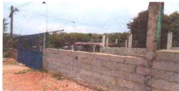
Foto 4: MURO PERIMETRAL (SUSTITUCION DE MALLA GALVANIZADA )
