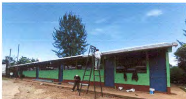
Foto 3: CANALES Y BAJADAS DE AGUA PLUVIAL SUSTITUCION CANAL CUADRADO DE LAMINA CALIBRE 13
