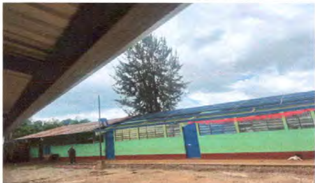
Foto 1: CUBIERTA DE LÁMINA SUSTITUCION LAMINA TROQUELADA CALIBRE 26
