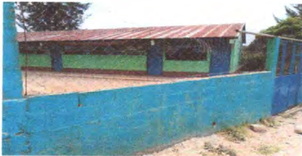
Foto 1: CUBIERTA DE LÁMINA (SUSTITUCION LÁMINA TROQUELADA CALIBRE 26 )
