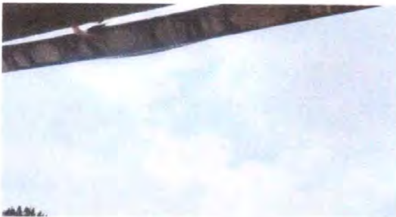
Foto 3: CANALES Y BAJADAS DE AGUA PLUVIAL (SUSTITUCION CANAL CUADRADO DE LÁMINA GALVANIZADA CALIBRE 13 )
