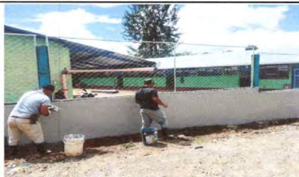
Foto 4: MURO PERIMETRAL SUSTITUCION DE MALLA GALVANIZADA
