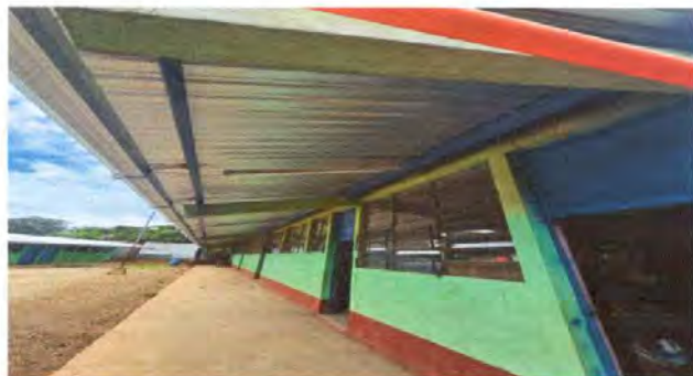
FOTO 1: SUSTITUCION DE LÁMINA TROQUELADA CALIBRE 26
