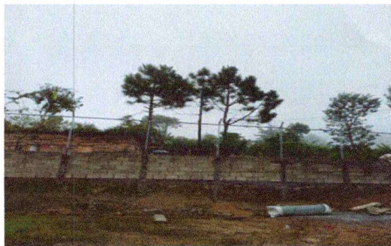
FOTO 2: Reparación de cerco perimetral con block y malla
