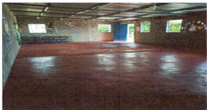
Foto 1: Reparación de piso de concreto
