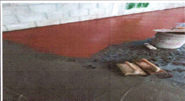
Foto 1: Reparación de piso de concreto
