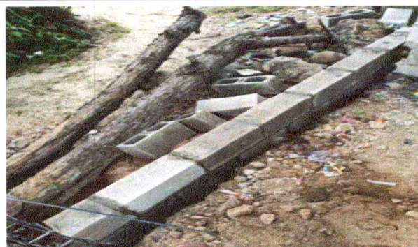
FOTO 2: Reparación de cerco perimetral con block y malla
