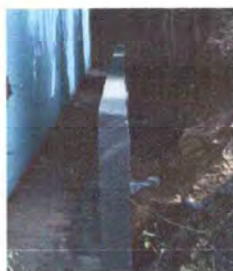
Foto 5: Fundición de muro de contención.
