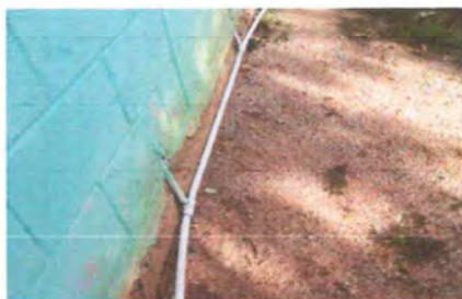
Foto 3: Reparación de drenajes, tuberías de baños y agua.
