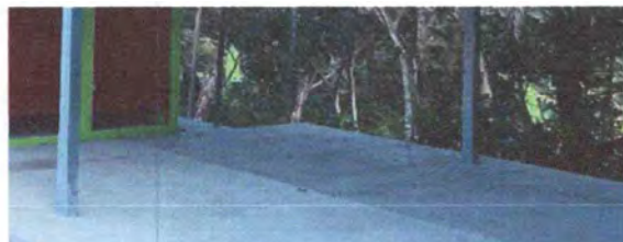
Foto 2: Demolición, sustitución y fundición de losa de patio.
