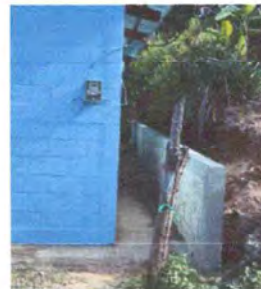
Foto 4: Reparación de sistema eléctrico.
