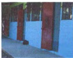
Foto 1: Sustitución, reparación y mantenimiento de puertas de aulas con sus chapas.
