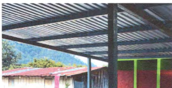
9. Reparación, fijación e instalación de soportes en techo.
