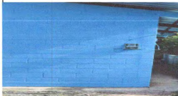
Foto 8: PINTURA EN MUROS INTERIORES Y EXTERIORES.
