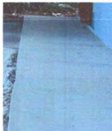
Foto 7 : Sustrucción de banquetas, colocación de tuberías y otros.
