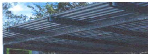
Foto 6: Reparación, sustitución de techos y estructura de techo.
