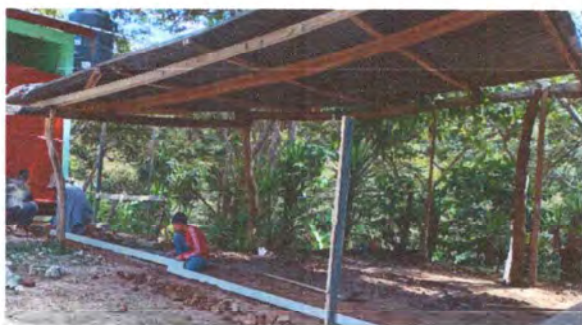
9. Reparación, Fijación e instalación de soportes en techo.
