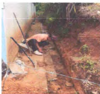
Foto 5: Fundición de muro de contención.
