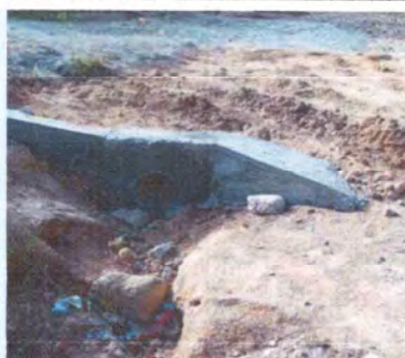
Foto 7 : Sustitución de banquetas, colocación de tuberías y otros.
