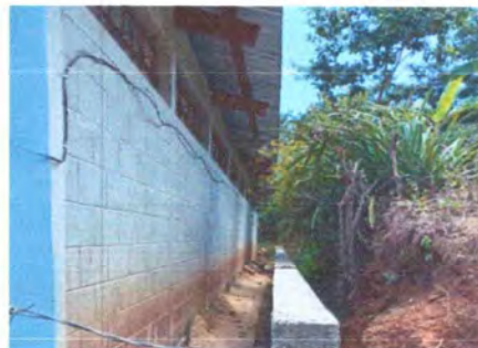
Foto 4: Reparación de sistema eléctrico.
