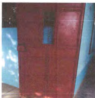
Foto1: Sustrucción, reparación y mantenimiento de puertas de aulas con sus chapas.
