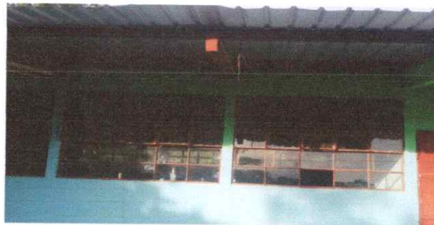
Foto 8: PINTURA EN MUROS INTERIORES Y EXTERIORES.
