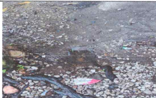
Foto 2: Demolición, sustitución y fundición de losa de patio.
