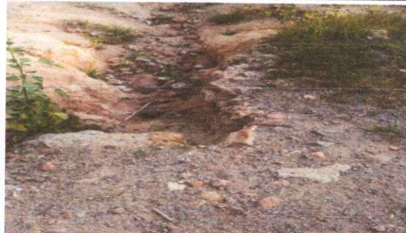
Foto 7 : Sustrucción de banquetas, colocación de tuberías y otros.
