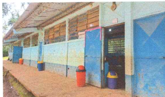
Foto 2: Sustitución de vidrios
