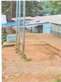
Foto 8: Sustrucción losa de patio
