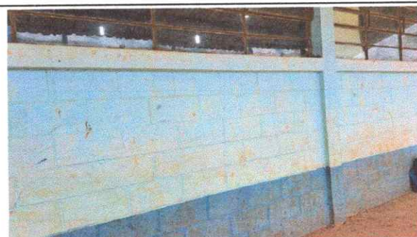
Foto 5: Sustitución de pintura base aceite
