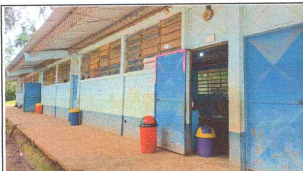
Foto 4: Sustitución de pintura base agua
