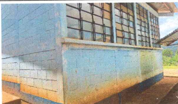
Foto 3: Sustitución de pintura base agua
