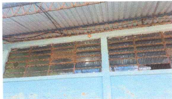
Foto 1: Sustitución de vidrios
