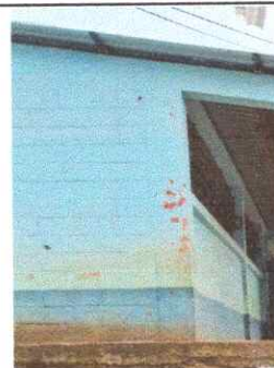
Foto 6: Sustitución de pintura base aceite
