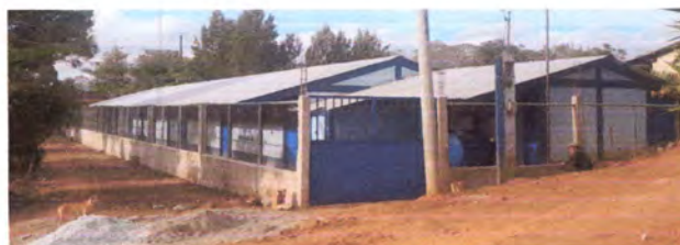
Foto 4: FINALIZACIÓN DE SUMINISTRO E INSTALACIÓN DE MURO DE CERRAMIENTO CON INSTALACIÓN DE MALLA HEXAGONAL CON TUBO GALVANIZADO DE 2"
