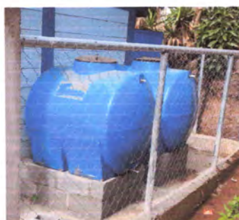
Foto 6: FINALIZACIÓN DE SUSTITUCIÓN DE BASE PARA TINACO, INCLUYE SUMINISTRO E INSTALACIÓN DE ACCESORIOS PARA TINACO REFORZADO.
