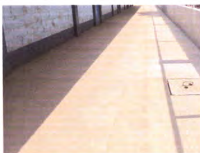
Foto 5: FINALIZACIÓN DE SUSTITUCIÓN DE TORTA DE CONCRETO.
