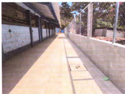
Foto 3: FINALIZACIÓN DEMOLICIÓN DE MURO PERIMETRAL EXISTENTE PARA REEMPLAZAR CON CERRAMIENTO DE MURO CON CIMIENTO CORRIDO.
