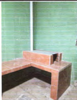
Foto 1: FINALIZACIÓN DE SUMINISTRO E INSTALACIÓN DE DOS COCINAS RURALES COMPLETAS.
