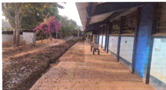
Foto 5: SUSTITUCIÓN DE TORTA DE CONCRETO.
