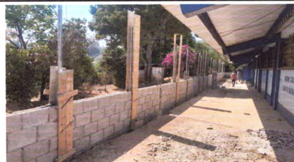
Foto 4: SUMINISTRO E INSTALACIÓN DE MURO DE CERRAMIENTO CON INSTALACIÓN DE MALLA HEXAGONAL CON TUBO GALVANIZADO DE 2"
