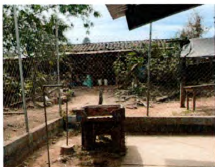
Foto3: DEMOLICIÓN DE MURO PERIMETRAL EXISTENTE PARA REEMPLAZAR CON CERRAMIENTO DE MURO CON CIMENTO CORRIDO.
