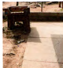
FOTO 2: SUMINISTRO E INSTALACIÓN DE PILA DE 2 LAVADEROS EN ÁREA EXTERIOR DE COCINA.
