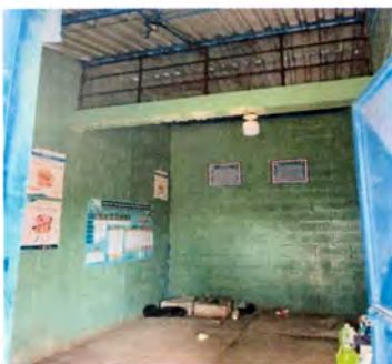
Foto1: SUMINISTRO E INSTALACIÓN DE 2 COCINAS RURALES COMPLETAS
