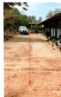
Foto4: SUMINISTRO E INSTALACIÓN MURO DE CERRAMIENTO, CON INSTALACIÓN DE MALLA HEXAGONAL CON TUBO GALVANIZADO DE 2 "
