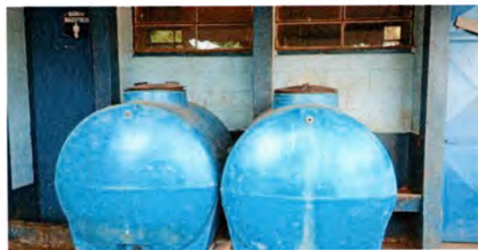
Foto: 6 SUSTITUCIÓN DE BASE PARA TINACO INCLUYE SUMINISTRO E INSTALACIÓN DE ACCESORIOS PARA TINACO REFORZADO.
