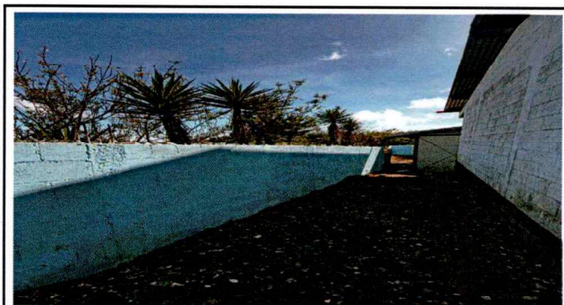
Foto 3: Se observa la finalización del muro perimetral que fue reconstruido en la Escuela por el Programa mantenimiento de Edificios Escolares Públicos.
