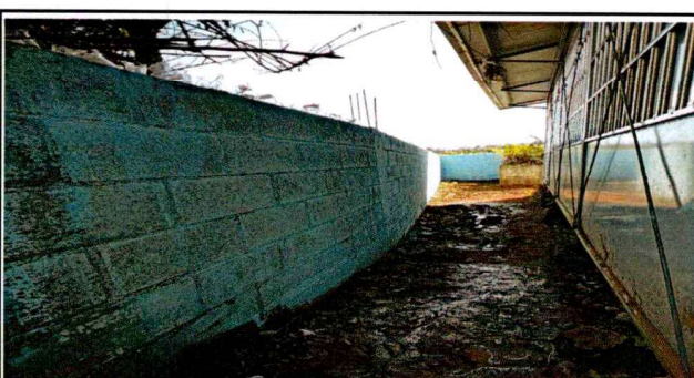
Foto 4: Se observa la finalización del muro perimetral que fue reconstruido en la Escuela por el Programa mantenimiento de Edificios Escolares Públicos.
