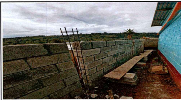
Foto 2: Se observa la reconstrucción de muro perimetral en proceso o termino medio que se realiza en la Escuela.
