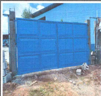
Foto 3: SUSTITUCION DE PORTON DE TUBO CON LAMINA LISA (4*2MTS)
