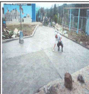
Foto 5: SUSTITUCION LOSA DE PATIO INCLUYE BASE Y FUNDICION
