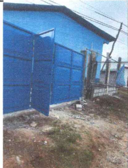
Foto 3: SUSTITUCION DE PORTON DE TUBO CON LAMINA LISA (4*2MTS)
