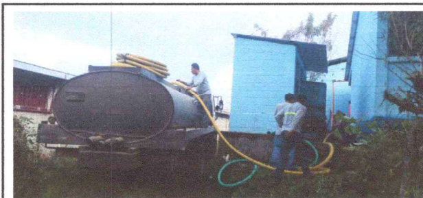
Foto 6: REPARACION Y MANTEMIENTO DE FOSA
