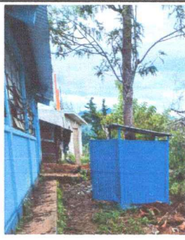
Foto1: SUSTITUCION DE LAMINA TROQUELADA CALIBRE 26
