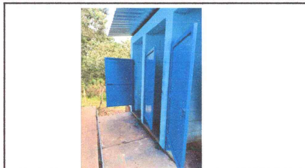
Foto 2: REPARACION Y MANTENIMIENTO DE PUERTAS DE BAÑO
