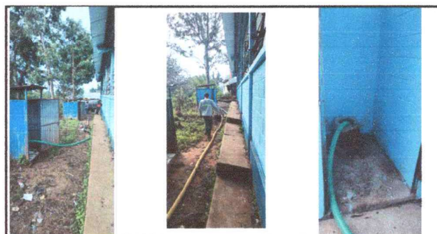
Foto 6: REPARACION Y MANTEMIENTO DE FOSA
