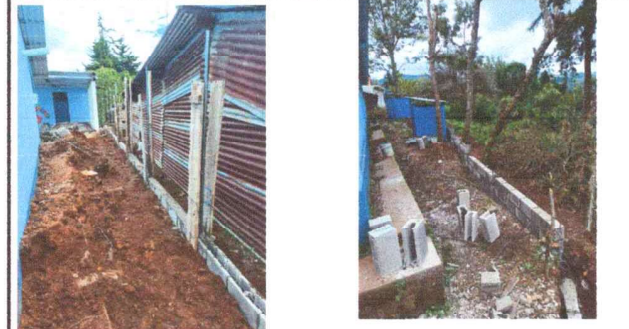
Foto 4:REPARACION DE CERCO PERIMETRAL MALLA
