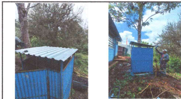
Foto1: SUSTITUCION DE LAMINA TROQUELADA CALIBRE 26
