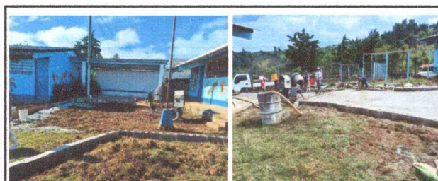
Foto 5: SUSTITUCION LOSA DE PATIO INCLUYE BASE Y FUNDICION
