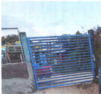
FOTO 7: sustitución de portón
