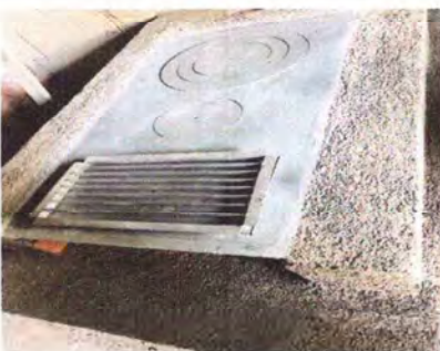
Foto 11: reparación o sustitución del área de cocina
