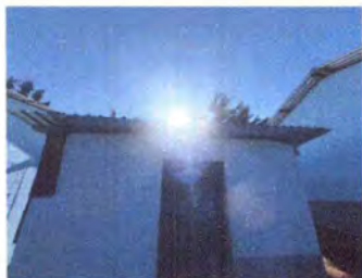
FOTO 1: cubierta de lámina
