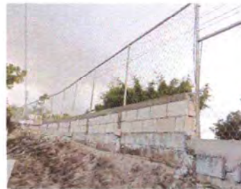
Foto 8: cerco muro perimetral
