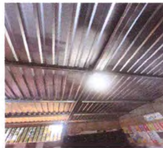
Foto 10: reparación del sistema eléctrico
