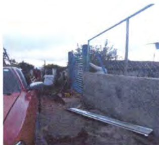
FOTO 7: sustitución de portón
