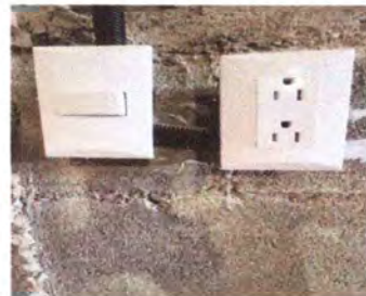
Foto 10: Reparación del sistema eléctrico
