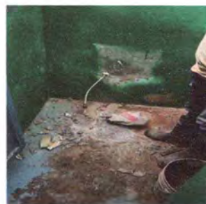
Foto 6: servicio sanitario y sus accesorios
