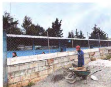
Foto 8: cerco muro perimetral
