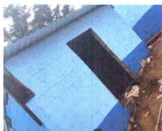
FOTO 1: Cubierta de lámina
