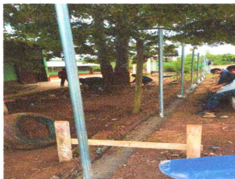
Foto 2: CIMIENTO PREPARADO PARA LA COLOCACION DE LAS 4 HOLADAS DE BLOCK.
