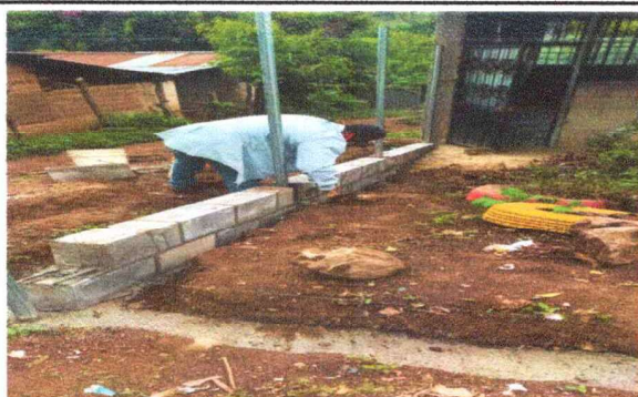
Foto 3: INICIAN A PEGAR LAS HILADAS DE BLOCK.
