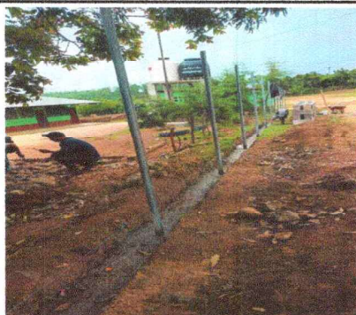
Foto 1: INICIA LA FUNDICION DE CIMIENTO Y COLOCACION DE TUBOS GALVANIZADO.
