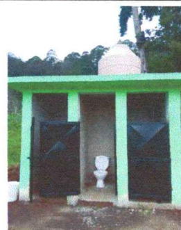
Foto 4: Cambio de sanitarios.
