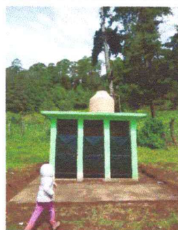
Foto 2: Reparación de puertas y mantenimiento de tinaco en sanitarios.
