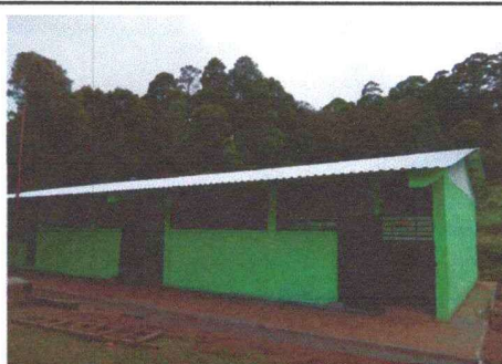
Foto 6: Reparación de techo en aulas.
