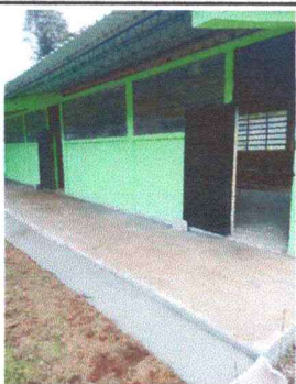
Foto 1: Reparación de aulas, pintado y lijado.
