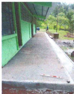
Foto 3: Reparación de piso de aulas.
