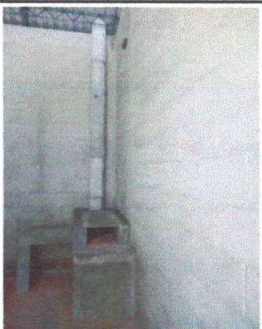
Foto 5: Reparación de hornillas de la cocina.
