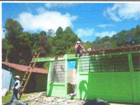
Foto1: Cambio de techo
