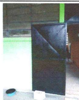
Foto 2: Mantenimiento de puerta de aulas.
