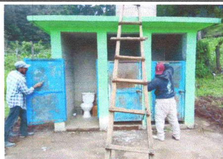
Foto 6: Reparación de puertas y tinaco de los sanitarios.
