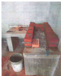
Foto 5: Reparación de cocina.
