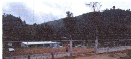
Foto 2:FINALIZACIÓN DE SUSTITUCION DE PORTÓN
