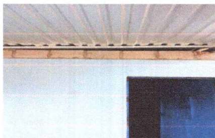
Foto1: FINALIZACIÓN DE LA SUSTITUCIÓN DE LA LAMINA
