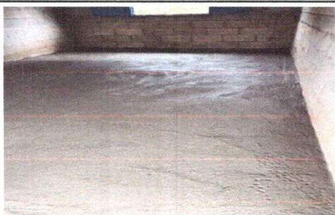
Foto 3: FINALIZACIÓN DE SUSTITUCIÓN DEL PISO DE CEMENTO
