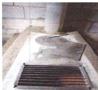
Foto 4: FINALIZACIÓN DE SUSTITUCIÓN DEL AREA DE COCINA
