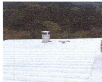
Foto 2: SUSTITUCIÓN DE LAMINA TROQUELADA
