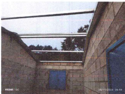
Foto 1: SUSTITUCIÓN DE TECHO DE MADERA POR COSTANERAS DE METAL
