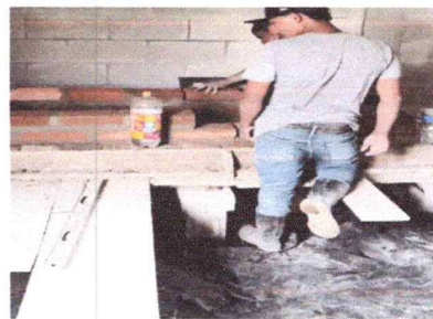
Foto 4: SUSTITUCIÓN DEL AREA DE COCINA
