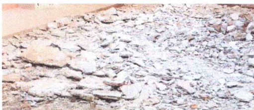
Foto 3: SUSTITUCIÓN DEL PISO DE CEMENTO
