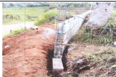
Foto 6: SUSTITUCION DE CERCO A MURO PERIMETRAL DE MALLA
