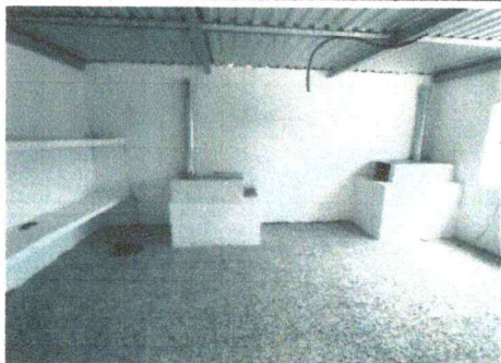
Foto1:Terminado colocación piso
