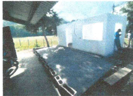
Foto2: Haciendo nueva banqueta
