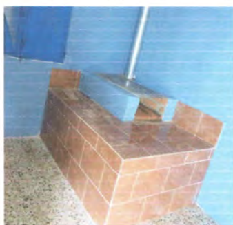
Foto 5: Finalización de reparación de estufa rural completa.
