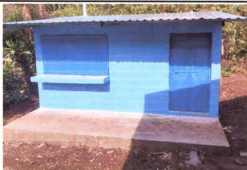
Foto 3: Finalización de reparación de paredes de cocina.
