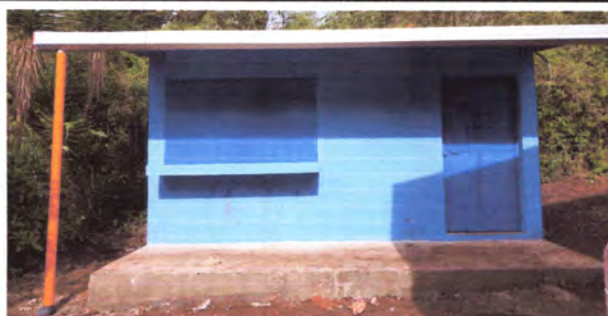
Foto 4: Finalización de reparación de canal y bajada de agua pluvial.
