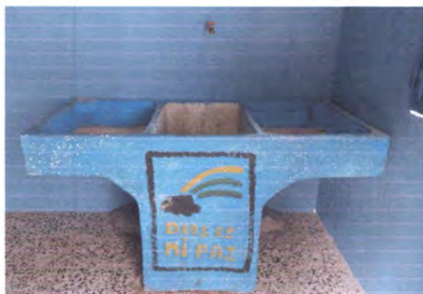
Foto 6: Finalización de reparación de pila.
