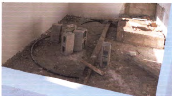
Foto1: Reparación base para piso de cocina.
