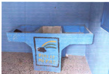
Foto 6: Reparación de pila.
