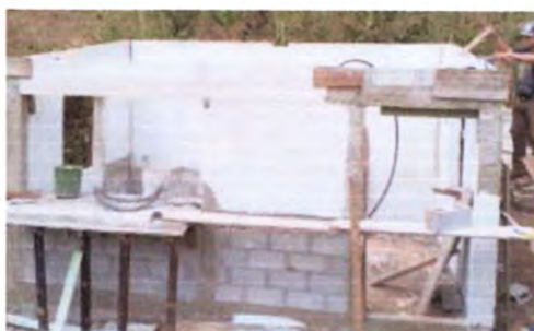
Foto 3: Reparación de paredes de cocina.
