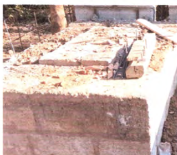
Foto 5: Reparación de estufa rural completa.
