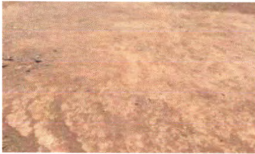
Foto1: Reparación base para piso de cocina
