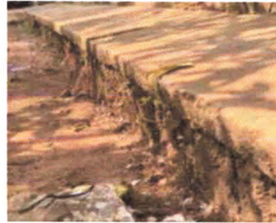
FOTO 2: Reparación de banquetta frente al área de cocina
