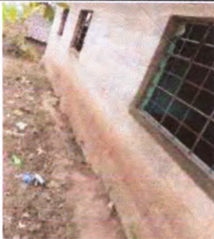
Foto3: Reparación de paredes de cocina
