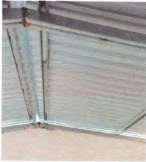
Foto1: Instalación de lámina Aluzinc calibre 26
