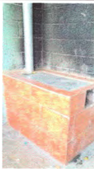
Foto3: Reparación de estufa rural
