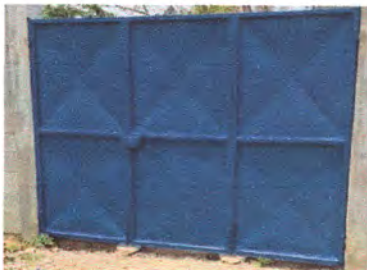
Foto: 5 Mantenimiento a porton de metal lijado, cepillado, sujeciones, aplicación de 2 manos de pintura anticorrosiva)
