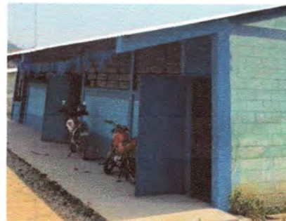
Foto4: Mantenimiento a puertas de metal lijado, cepillado, sujeciones, aplicación de 2 manos de pintura anticorrosiva)
