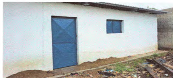
Foto: 6 Sustitución de puerta
