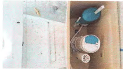
FOTO 2: Sustitución de accesorios de inodoro (contra llave, tubo de abasto y kit de tanque)
