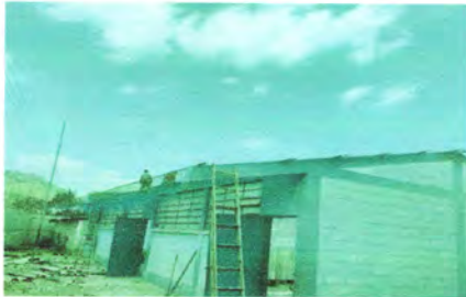
Foto1: Instalación de lámina Aluzinc calibre 26
