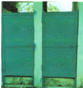
Foto 3: Mantenimiento a puerta de metal fijado, cepillado, sujeciones, aplicación de 2 manos de pintura anticorrosiva)
