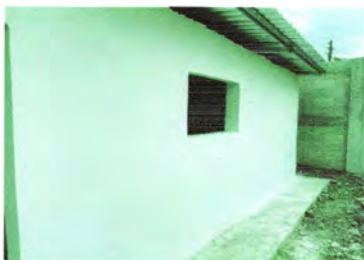
Foto: 5 Reparación de ventana
