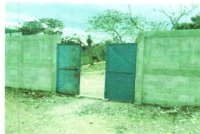
Foto 4: Mantenimiento a porton de metal fijado, cepillado, sujeciones, aplicación de 2 manos de pintura anticorrosiva)
