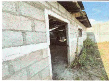
Foto4: Sustitución de lámina Aluzinc calibre 26
