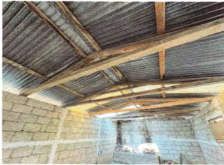
Foto3: Sustitución de base para techo
