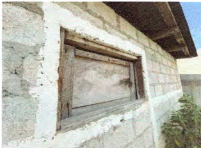
Foto: 5 Sustitución de ventana
