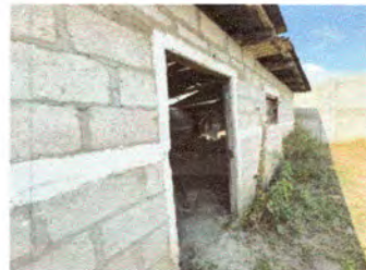
Foto: 6 Sustitución de puerta
