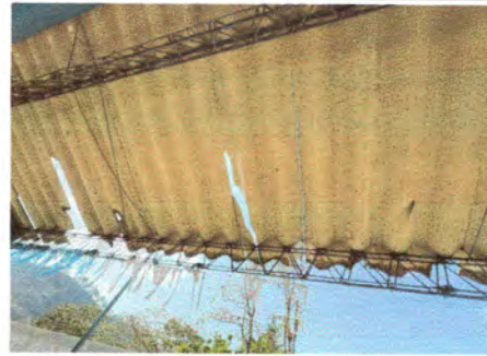
FOTO 2: Instalación de lámina Aluzinc calibre 26
