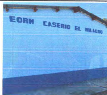
Foto 6: PINTURA EN MURO INTERIOR Y EXTERIOR
