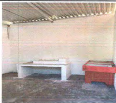
Foto 8: REPARACIÓN O SUSTITUCIÓN DE AREA DE COCINA (ESTUFA RURAL, VENTANA, PUERTA, PAREDES, CHIMENEA)
