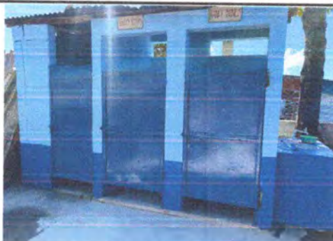
Foto 3: SUSTITUCIÓN DE PUERTAS EN AREA DE AULAS Y BAÑOS
