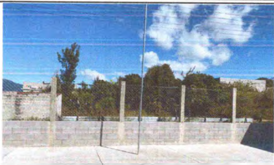
Foto 7: SUSTITUCIÓN DE CERCO PERIMETRAL CON BLOCK Y MALLA
