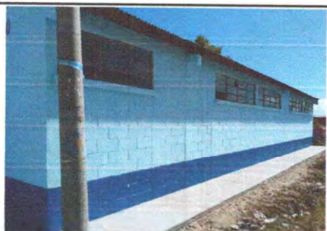
Foto 5: SUSTITUCIÓN DE CUNETETA DE CONCRETO
