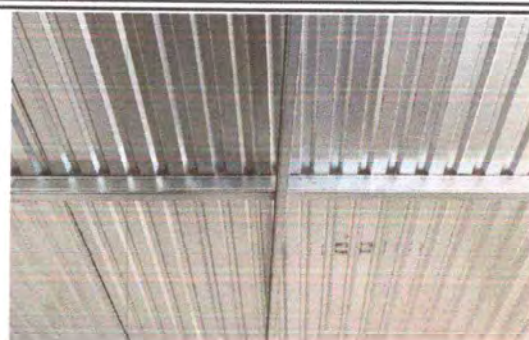
Foto 2: SUSTITUCIÓN DE ESTRUCTURA DE TECHO
