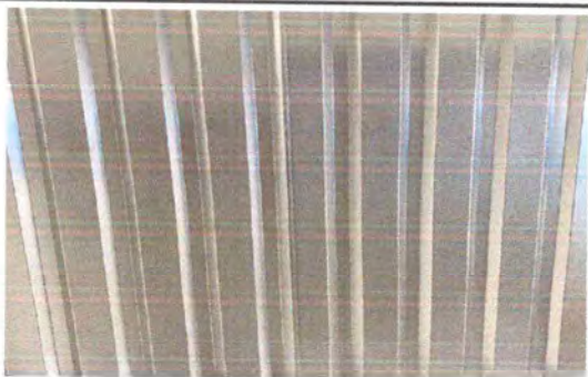
Foto1: SUSTITUCIÓN DE LAMINA ACANALADA CALIBRE 26
