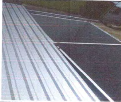
Foto 1: SUSTITUCIÓN DE LAMINA ACANALADA CALIBRE 26
