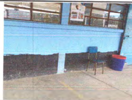
Foto 6: PINTURA EN MURO INTERIOR Y EXTERIOR
