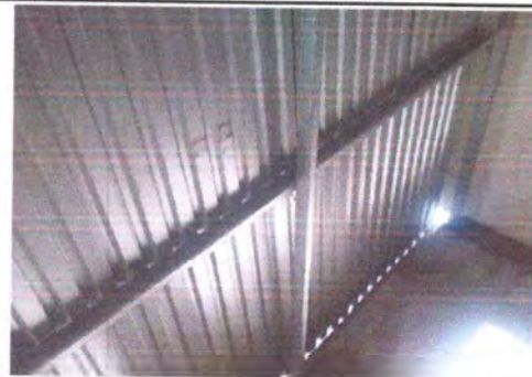
Foto 2: SUSTITUCIÓN DE ESTRUCTURA DE TECHO
