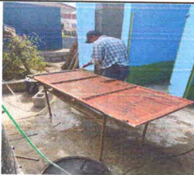
Foto 3: SUSTITUCIÓN DE PUERTAS EN AREA DE AULAS Y BAÑOS
