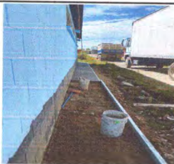
Foto 5: SUSTITUCIÓN DE CUNETETA DE CONCRETO
