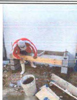
Foto 8: REPARACIÓN O SUSTITUCIÓN DE AREA DE COCINA (ESTUFA RURAL, VENTANA, PUERTA, PAREDES, CHIMENEA)
