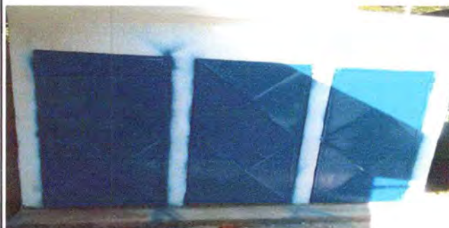
FOTO 2: Sustrucción de puertas en area de baños
