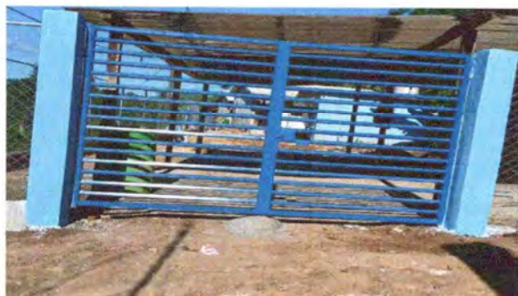
Foto 7: Reparación y mantenimiento de portón
