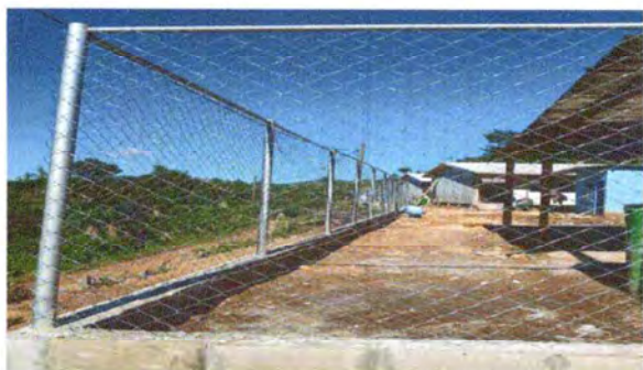
Foto 1: Sustrucción de cerco perimetral con muro y malla
