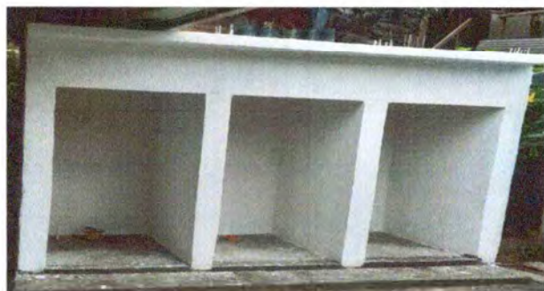
Foto 5: Sustrucción de repello y cernido
