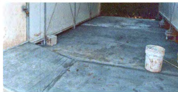
Foto 6: Sustrucción de losa de patio, incluye base y acabado
