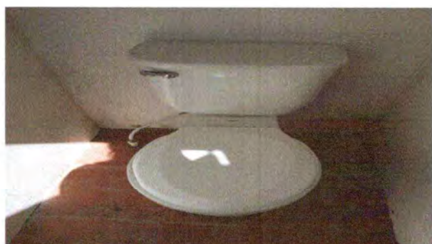
Foto 3: Sustrucción de sanitarios completos
