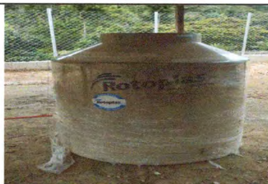
Foto 4: Reparación y mantenimiento de depósito de agua
