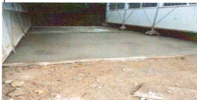
Foto 6: Sustitución losa de patio, incluye base y acabado
