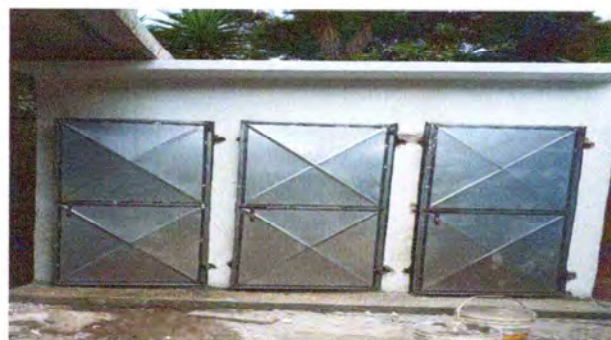
FOTO 2: Sustitución de puertas en área de baños
