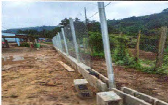
Foto 1: Sustitución de cerco perimetral con block y malla
