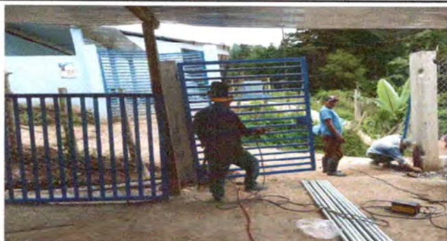
Foto 7: Reparación y mantenimiento de portón
