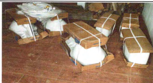
Foto 3: Sustitución de sanitarios completos
