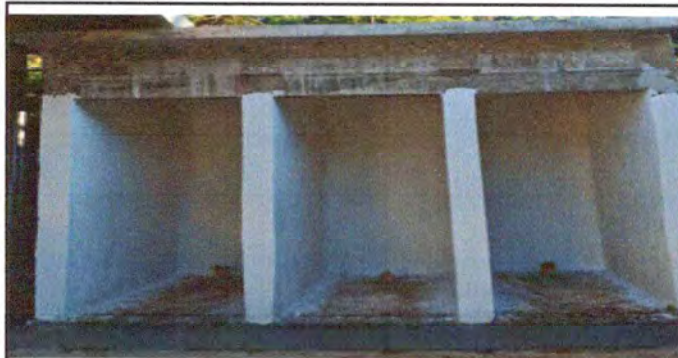
Foto 5: Sustitución de repello y cernido
