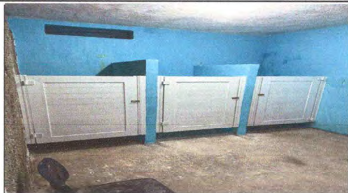
Foto 7: Servicios Sanitarios (incluye cambio de tubería y profundizar pozo)
