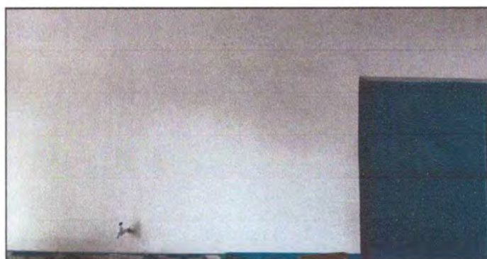
Foto 5: Pintura en muros interiores
