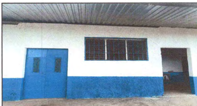
Foto 6: Pintura en muros exteriores
