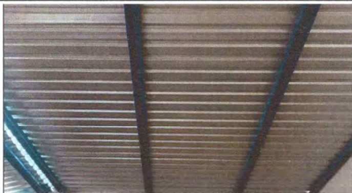
Foto 1: Cubierta de Lámina: ubicado en la cocina del Centro Educativo
