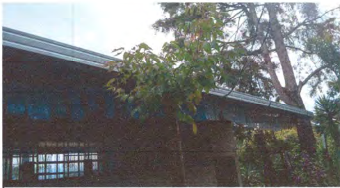
Foto 4: Canales y bajadas de agua Pluvial en el Centro Educativo
