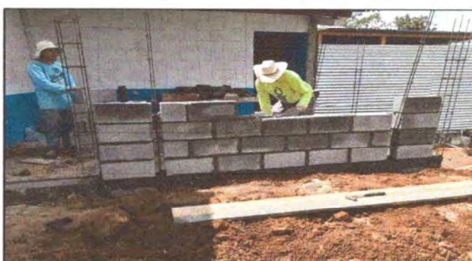
Foto 10: Reparación o sustitución de area de cocina (estufas rurales, pilas, ventanas, puertas, chimenea, etc.)
