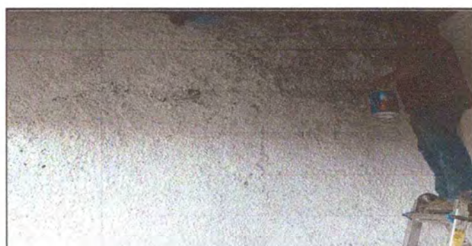
Foto 6: Pintura en muros exteriores
