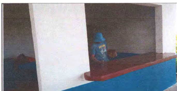
Foto 5: Pintura en muros interiores
