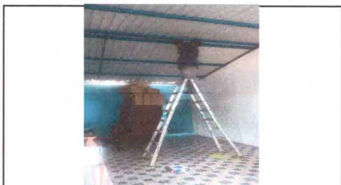
Foto 9: Reparación del sistema eléctrico en área de cocina y servicios sanitarios
