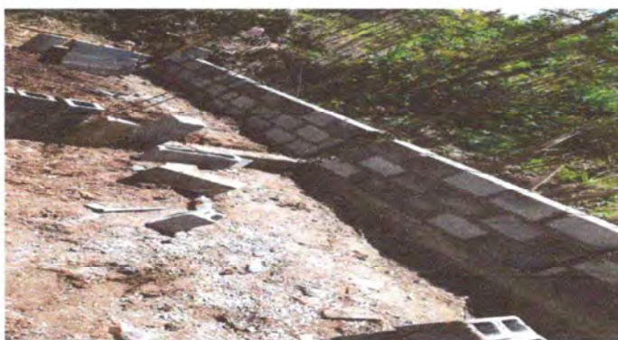
Foto 3: Cerco o Muro Perimetral en el Centro Educativo
