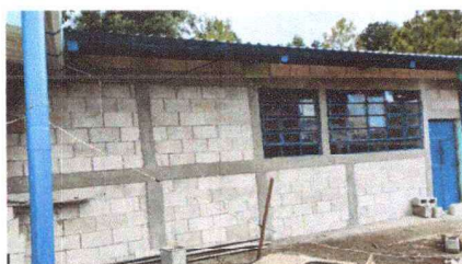
Foto 5: Sustitución de muro perimetral
