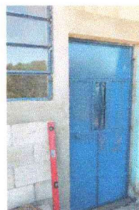
Foto 2: Sustitución de puerta en área de aulas
