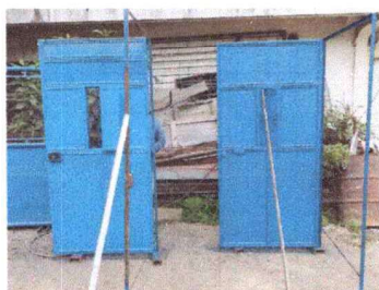
Foto 3: Reparación y mantenimiento en puerta de aulas
