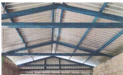
Foto 1: Sustitución de lámina troquelada calibre 26 y sustitución de estructura de techo
