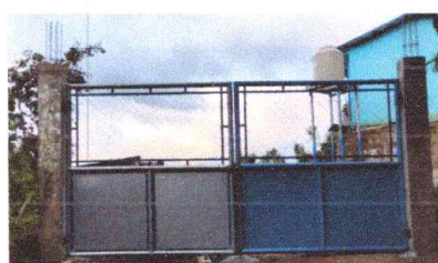
Foto 4: Sustitución de portón con tubo y malla
